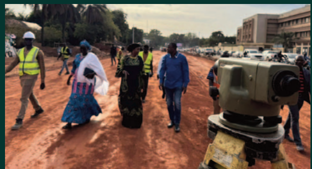
Ministère des Transports... : Début des travaux d'aménagement de la route nationale n°07 (RN7)
