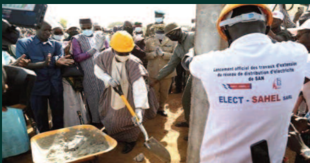
Extension du réseau de distribution électronique de San : Le PM lance les travaux
